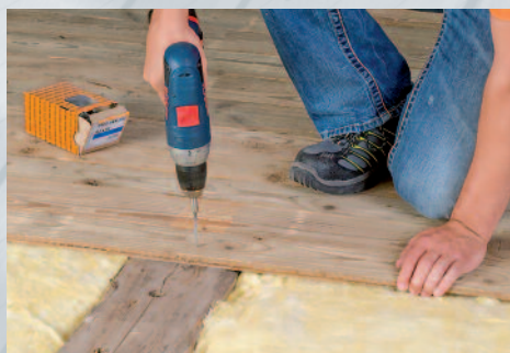
Bevestiging van vloerplanken
